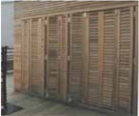
Principe de volet à persiennes
