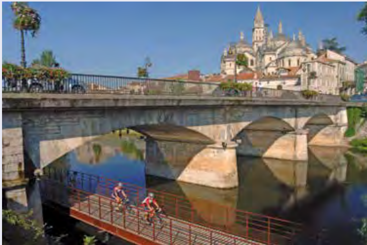
Réalisation d'une passerelle pour piétons et cyclistes le long des berges de la rivière Isle à Périgueux. Crédit : Denis Nidos.
