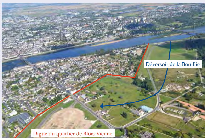
Déversoir de la Bouillie, aux franges du quartier endigué de Blois-Vienne, 2006.
