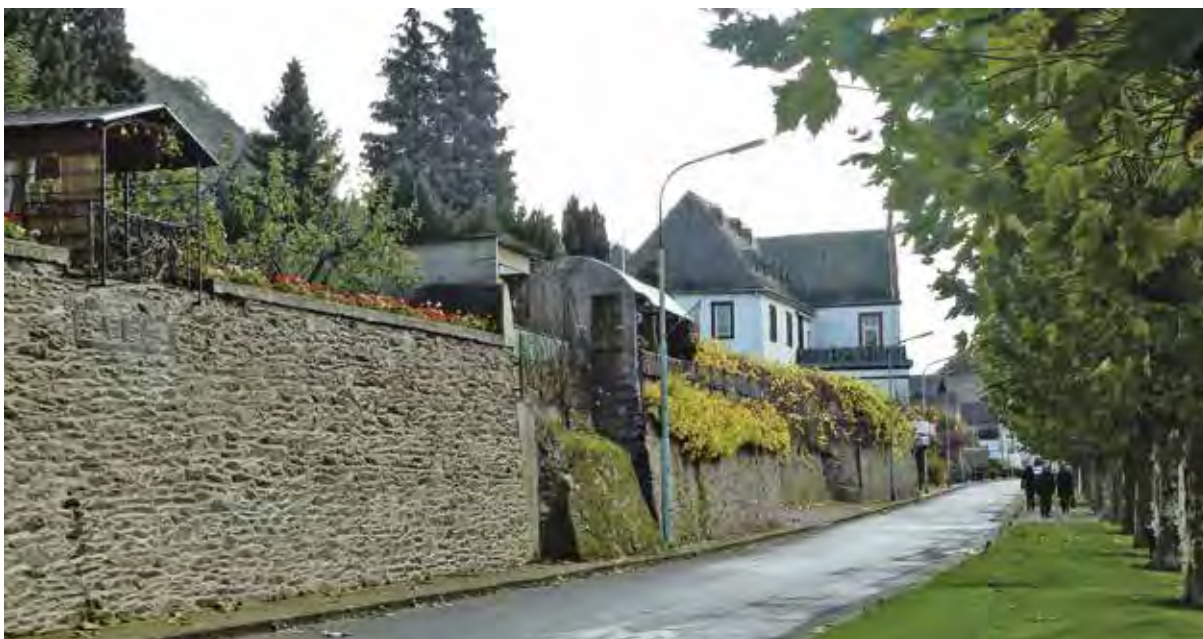
Mur de protection contre les crues du Rhin, à Leutesdorf (Allemagne). Crédit : CEPRI.
