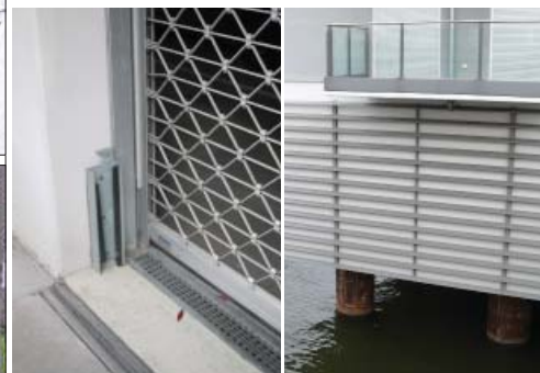
Porte de garage poreuse Bâtiment sur pilotis
