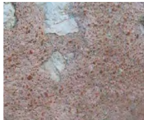
Enduit au mortier de tuileau (Photos : STAP du Loiret)
